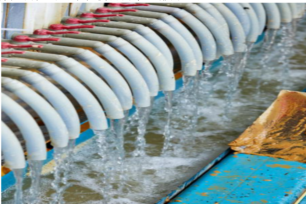
泥浆压缩过程中排出的清水
