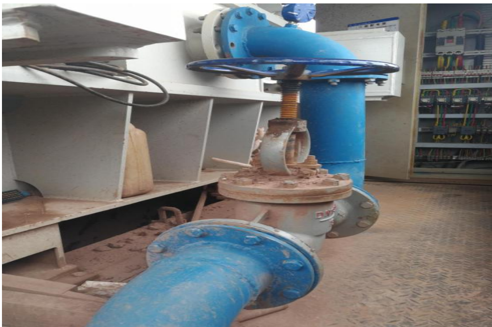
泥浆泵送滤室过程
