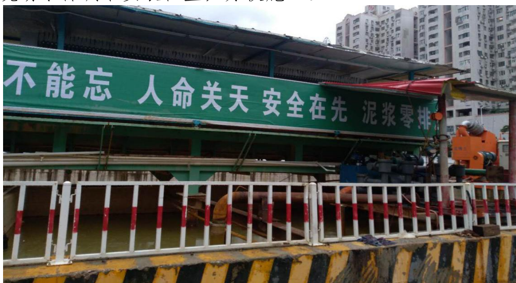
如意坊项目泥浆脱水平台组装现场
